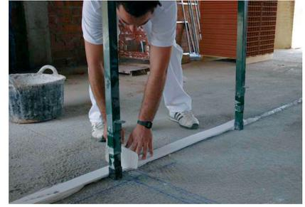
3. Tout au long de l'implantation, installer les bandes élastiques périmétriques qui isolent la cloison du reste des éléments structuraux.
