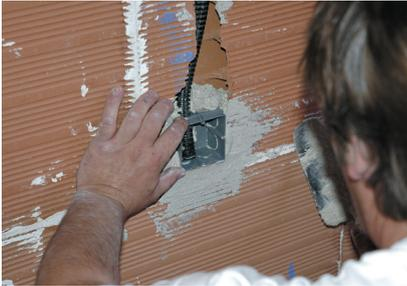
**13.** Une autre option est celle de réaliser une finition avec des plaques de plâtre laminé (PYL). Il est très important que les boitiers dépassent de 15 mm pour que une fois coller la plaque de plâtre laminé Pyl ceux-ci restent affleure.
