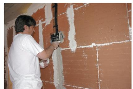
12. Une fois scellés les gaines, les boîtiers et les installations, la Planéité 100% et l'absorption inférieure à 10% permettent un enduit parfait, avec un plâtre humide (6-15 cm).
