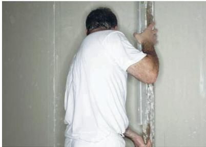
**17.** Pour l'ajustement parfait de la plaque de plâtre laminé avec la brique céramique il est indispensable d'utiliser la règle. Ainsi la cloison Hispalam est prête pour l'installation des bandes.
