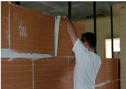
7. L'installation des rangs doit être à joint croisé, ne pas les faire coïncider verticalement.
