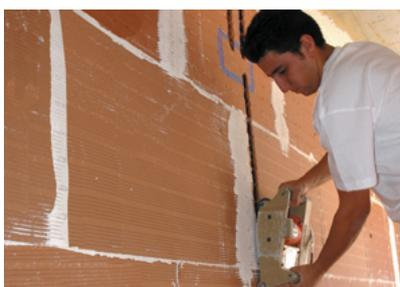
11. De nouveau, grâce à la qualité de la brique céramique HispaPlano, les saignées et entailles se réalisent proprement.
