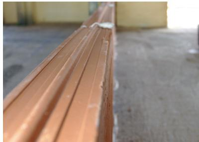
5. Les pièces de brique céramique ont une rainure et un nerf qui permettent un emboîtement précis entre elles. La colle s'applique dans les rainures de chaque côté du nerf pour assurer la prise avec la pièce du rang supérieur.
