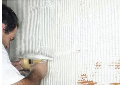
**14.** Une fois les plaques de plâtre laminé préparées, étalez la colle Hispalam sur toute la surface de la cloison à l'aide d'un platoir denté de 1cm.
