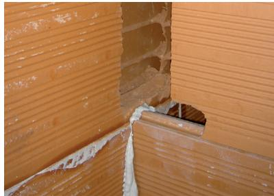
8. La jonction en T se réalise sur les rangs paires (2<sup>o</sup> et 4<sup>o</sup>). Grâce à la qualité des briques HispaPlano les jonctions se réalisent facilement et proprement, les pièces résultant parfaitement ajustées tout en maintenant leurs intégrités.
