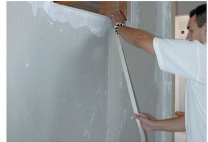
**18.** Il faut initialement appliquer la colle dans les joints entre les plaques. Poser la bande pour éviter les fissures sur la colle. Elle se maintient par une deuxième application de colle.
