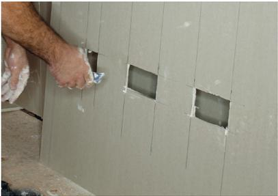
**16.** Marquer et réaliser les ouvertures dans les plaques nécessaires.
