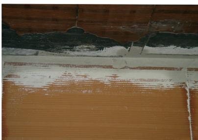
10. L'union avec le plancher supérieur se réalise en laissant un espace de 3 à 4 cm qui se comble avec un plâtre de prise contrôlée.
