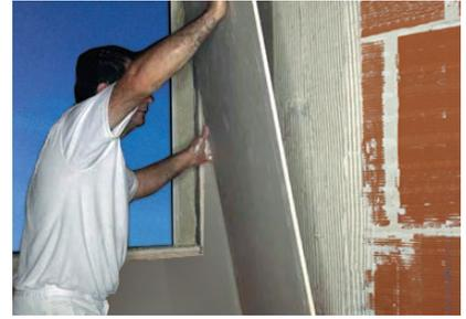
**15.** La stesura uniforme dell'adesivo è necessaria per la corretta adesione del pannello di cartongesso su tutta l'altezza della parete.
