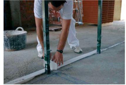
**3.** Lungo le tracce disegnate si sistemano le strisce elastiche perimetrali che isolano le pareti dal resto degli elementi strutturali.
