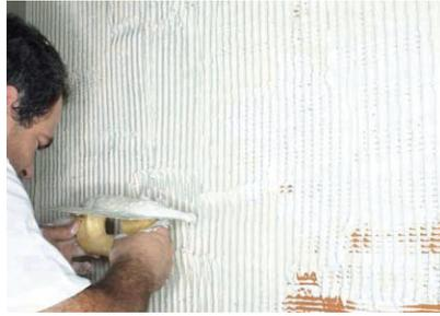
**14.** Una volta calcolata la posa dei pannelli di cartongesso, si stende uno strato di adesivo Hispalam con una cazzuola (con denti da 1 cm) su tutta la superficie.
