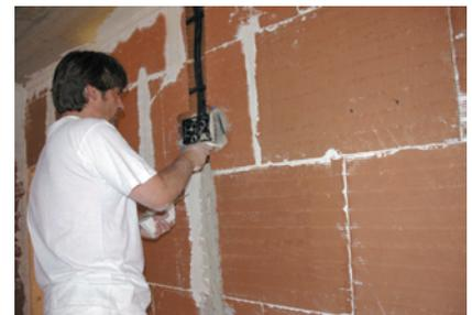
**12.** Una volta cementati i tubi, le canaline e le scatole degli impianti, la planarità 100% ed l'assorbimento minore del 10% permettono una perfetta finitura con intonaco umido (6- 15 mm).
