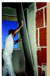
In seguito si incollano i pannelli di cartongesso, usando una riga di alluminio per ottimizzarne l'adesione. Si posizionano quindi delle bande in corrispondenza delle giunzioni, applicando un primo strato di pasta. Si sistema poi la seconda banda di carta e si applica il secondo strato di pasta. Quando è asciutto si dà una mano di finitura.
