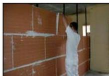
Grazie alle caratteristiche dell'argilla dei mattoni HispaPlano 100% le tracce verticali necessarie per il passaggio degli impianti si realizzano con facilità e precisione.
