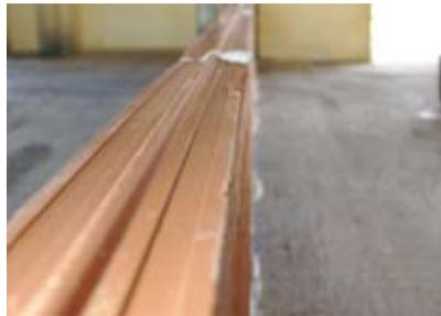
**5.** Die Ziegelsteine sind mit Nut und Feder ausgestattet, so dass für eine dauerhafte Verbindung zwischen den Steinen gesorgt ist. In den zwei Rinnen beidseits der Feder wird der Mörtel aufgebracht um die Verbindung mit den oberen Reihen sicher zu stellen.
