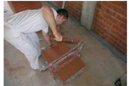
**6.** Das Einkürzen von Ziegeln Hispaplano erfolgt mittels Fliesenschneider. Durch die hohe Qualität des Ziegels teines kann der Schnitt sauber, präzise, schnell und einfach ausgeführt werden.
