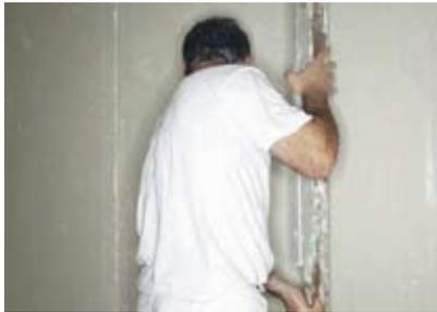
**17.** Für eine perfekte Anbringung der GKP ist es wichtig, dass die Fugen mit einer Mauerlehre verfüllt werden um eine gute Planfläche zu erreichen. Danach ist die Wandfläche fertig zu weiteren Bearbeitung mittels Papierstreifen.
