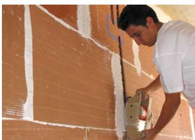
**11.** Aufgrund der hohen Qualität können die Kabelkanäle und Dosen mittels einer Doppelflex sauber ausgeschnitten werden.
