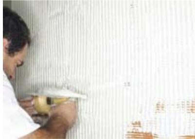
**14.** Sobald die Planung für die Anbringung der GKP abgeschlossen ist, wird der Ansetzbinder mittels einer geriffelten Putzkelle in der Dicke von 1cm aufgetragen.
