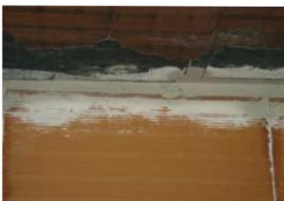
**10.** Die Verbindung zwischen der letzten oberen Ziegelreihe und der Decke wird hergestellt, indem die Spalte von 3 – 4 cm mit Gips verfüllt wird.
