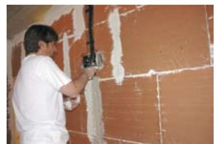
**12.** Wenn die Kabel und Dosen verlegt sind kann die Wand dank der hohen Planflächigkeit und der geringen Wasseraufnahmefähigkeit von < 10% ohne Probleme mit einem Gipsputz von 6 – 15 mm Stärke überzogen werden.
