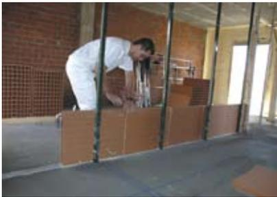
**4.** Bevor nun die unterste Reihe aufgesetzt wird, wird auf das Dichtungsband eine Schicht Kleber aufgebracht.
