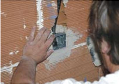
**13.** Eine andere Option ist die Endbehandlung mit Gipskartonplatten (GKP). Es ist sehr wichtig, dass die Dosen ca 15 mm über das Wandniveau herausragen, damit später ein glatter Abschluß mit den GKP gewährleistet ist.
