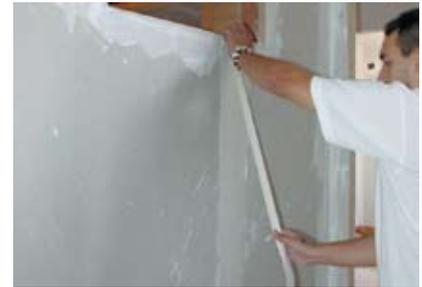
**18.** Die Papierstreifen werden über die Fugen angebracht und dann nochmals mit einen besonders feinkörnigen Gips abgezogen.
