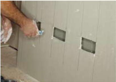
**16.** In die Platten können je nach Bedarf Löcher angebracht werden, damit auf die Elektrodosen zugegriffen werden kann.
