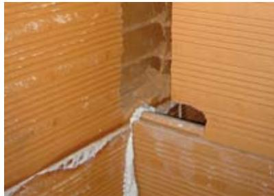
**8.** Der Verbund mit anderen Mauerwerken erfolgt in der 2. und 4. Reihe. Dank der hohen Qualität der Ziegelsteine können die Verbindungen einfach und sauber ausgeführt werden, verbleiben die Ziegel perfekt justiert und sich ihre Vollständigkeit erhaltend.
