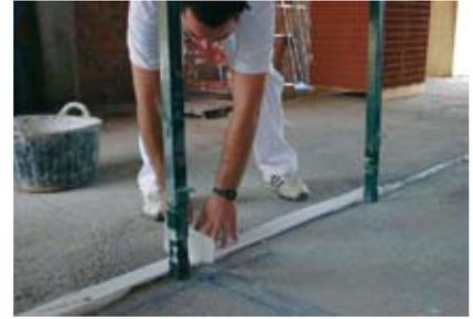
**3.** Entlang dieser Linie, wird das Ausgleichsband ausgelegt, welches später die Innenwand von den anderen konstruktiven Elementen trennen und thermisch isolieren wird.
