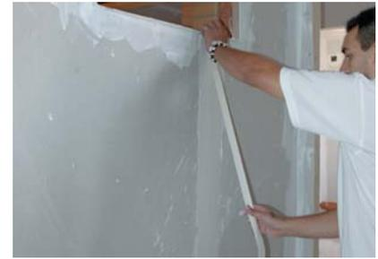
**18.** Inicialmente se deben cargar de pasta las juntas de las placas. Sobre la pasta se pega la venda o cinta de papel para evitar fisuras. Esta se sujeta con una segunda carga de pasta.
