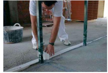
**3.** A lo largo del replanteo se colocan las bandas elásticas perimetrales que aíslan el tabique del resto de los elementos estructurales.
