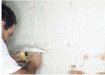
**14.** Una vez realizado el replanteo de las placas de yeso laminado, sobre la pared cerámica, se reparten masas equidistantes de pasta de agarre Hispalam que se extienden con llana dentada de 1 cm por toda la superficie.
