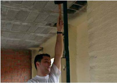
**1.** Para empezar, se colocan las reglas siguiendo el trazado que marca el replanteo sobre el forjado.
