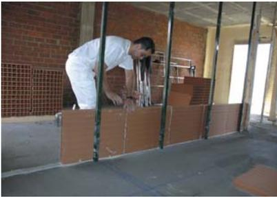
**4.** Antes de proceder a colocar la primera hilada de placa cerámica se echa cola sobre la banda perimetral para fijar el tabique.
