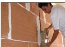
Debido a las características de las arcillas de HispaPlano 100 % las rozas verticales necesarias para las instalaciones se realizan fácilmente y con precisión.
