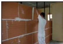
El proceso comienza con la colocación del ladrillo cerámico Gran Formato HispaPlano 100 % sobre una **banda elástica**. La unión de los ladrillos se realiza mediante la pasta de agarre Hispalam sobre las testas.
