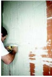
Una vez realizado el replanteo de las placas de yeso laminado, sobre la pared cerámica ya acabada y con una llana dentada de 1 cm, se aplica la pasta de agarre Hispalam sobre **TODA la superficie del ladrillo.**
