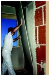
A continuación se pegan las placas de yeso laminado. Para un ajuste perfecto de las mismas se usa la regla de pañeo. Por último se realiza el encintado de las juntas, dando una primera carga de pasta de juntas. Posteriormente se coloca la venda o cinta de papel y se da una segunda carga de pasta. Cuando ya
