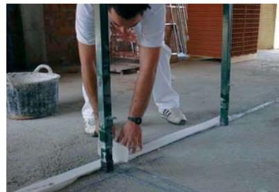
**3.** A lo largo del replanteo se colocan las bandas elásticas perimetrales que aíslan el tabique del resto de los elementos estructurales.
