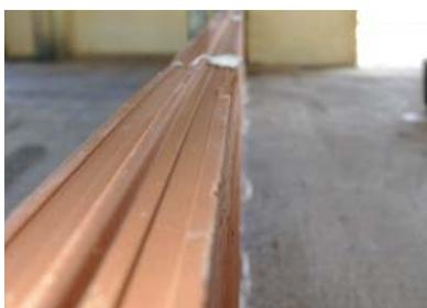
**5.** Las piezas de placa cerámica son machihembradas y encajan con precisión entre sí. Sobre las canaletas, a ambos lados de los machos, se aplica cola para asegurar el agarre con las piezas de la hilada superior.
